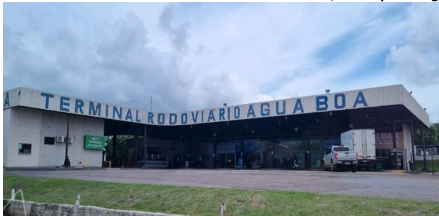
Figura 12 - Fachada do Terminal rodoviário vista da BR-158, município de Água Boa
